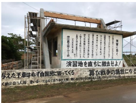
伊江島の団結道場（改修中）
