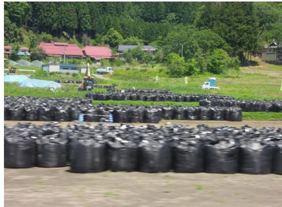
放射能汚染された土砂などを入れたフレコンバック
